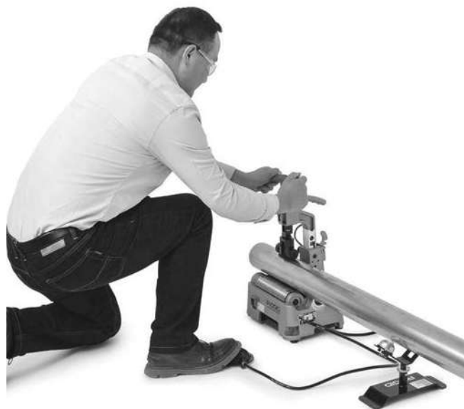
Figura 10 – Taglio delle tubazioni
